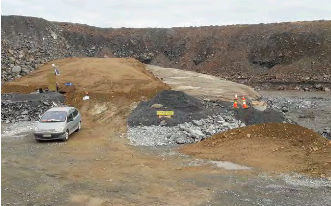
Kuva 2. Tapojärvi Oy:n toteuttama geopolymeerikoerakenne Kittilän kultakaivoksella
