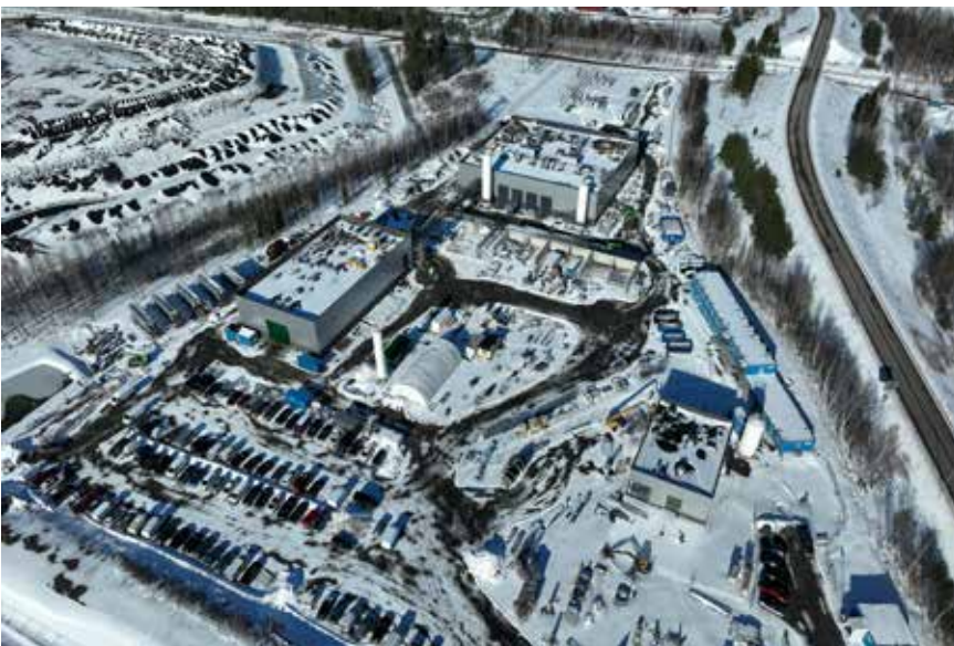
Harjavallan laitoksen työmaa maaliskuussa 2024
