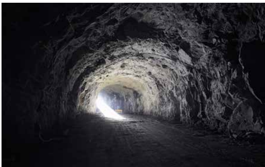
Valoa tunnelin päässä. Laakson yhteissairaalan louhinnoista on valmiina jo yli 80 %.
