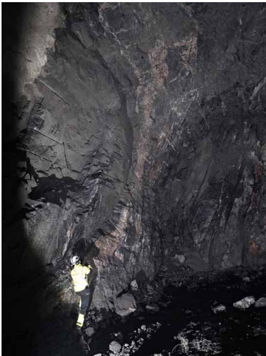
Geologi mittaamassa pääosin yli miljardi vuotta vanhoja rakenteita ja määrittämässä kalliolaatua kalliorakennesuunnittelijan lähtötiedoksi. Kiillegneissin liuskeisuus muodostaa alueella jatkuvia (> 10 m pitkiä) rakopintoja, jotka muodostavat paikoin laattamaista rakoilua tunnelin seinille.
