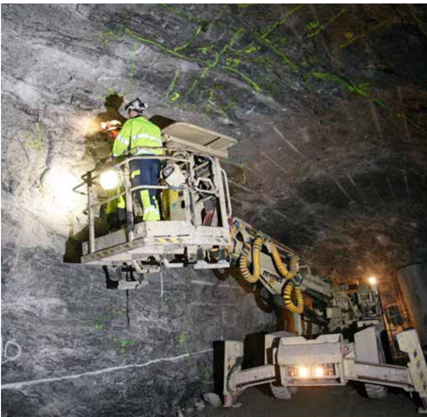
Hyperspektrimenetelmää voisi hyödyntää tunnelityömailla, esimerkiksi rakomineraalikartoituksessa.
