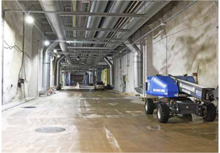
Poikittaiskäytäviä on 5, vesilinjoja 4 + tekniikkakäytävä ja linjalle 5 tehty tulevia louhintoja valmisteleva tunneli
