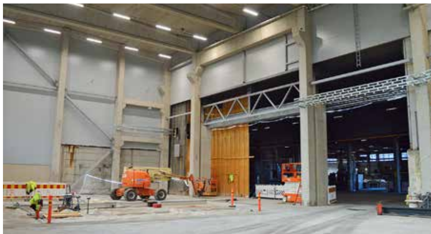
Uusi halli ja näkymä vanhalle puolelle
