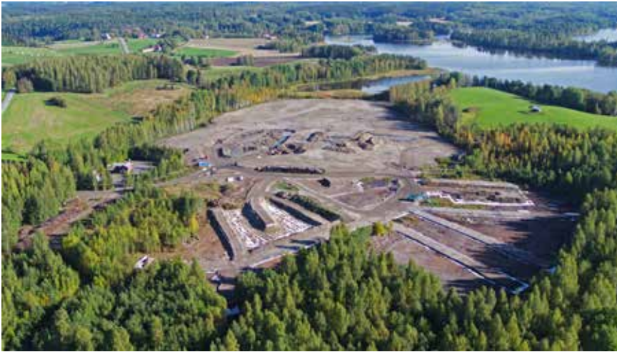
Ylöjärven Haverin rikastushiekka-alueita kunnostettiin läheiseltä tietyömaalta vapautuneella maa-aineksella. Kuva: Ylöjärven kaupunki
