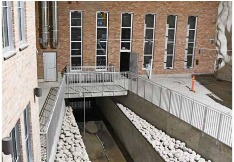
Puhdistettu vesi johdetaan virtausmittauksesta tunneliin ja edelleen Pyhäjärven pohjassa olevaan 1700 m pitkään purkuputkeen.
