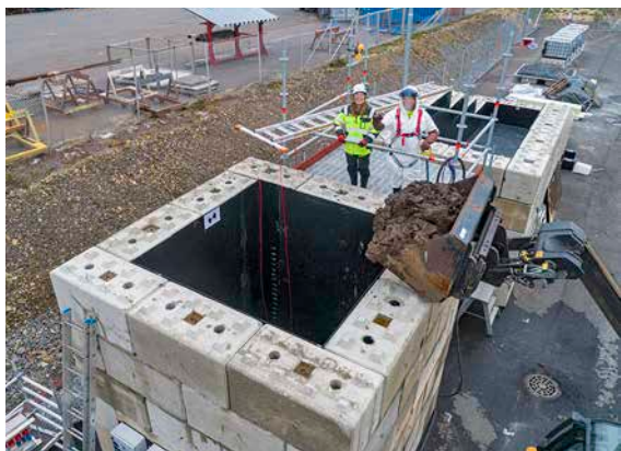
Rikastushiekan läjitysvaihe peittorakennetestaukseen
