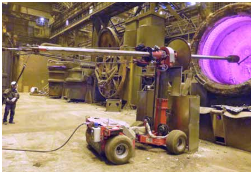
Kuva 2. Senkan vuorauksen korjaaminen ruiskuttamalla
