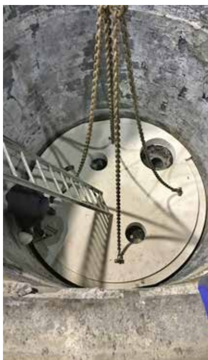
Terässenkan pohjaelementti asennusvaiheessa
