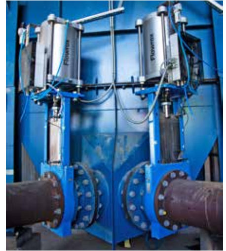
Sekä letkuventtiilit että levyluistiventtiilit – erityisesti vaativiin lietesovelluksiin suunnitellut mallit – tunnetaan pitkistä huoltoväleistään ja helppohuoltoisuudesta. Kuva: Valmet
