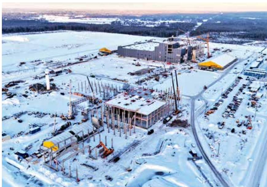
Tehtaan rakennustyöt alkoivat keuhalla 2025. Tammikuussa 2026 ne olivat edenneet jo pitkälle.
