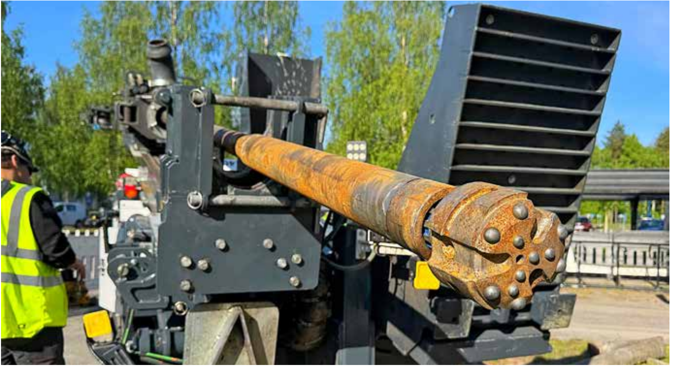
Oulun Linnanmaan kampusalueelle porattiin kaksi yli 600 metriä syvää energiakaivoa. Kuva: GTK.
