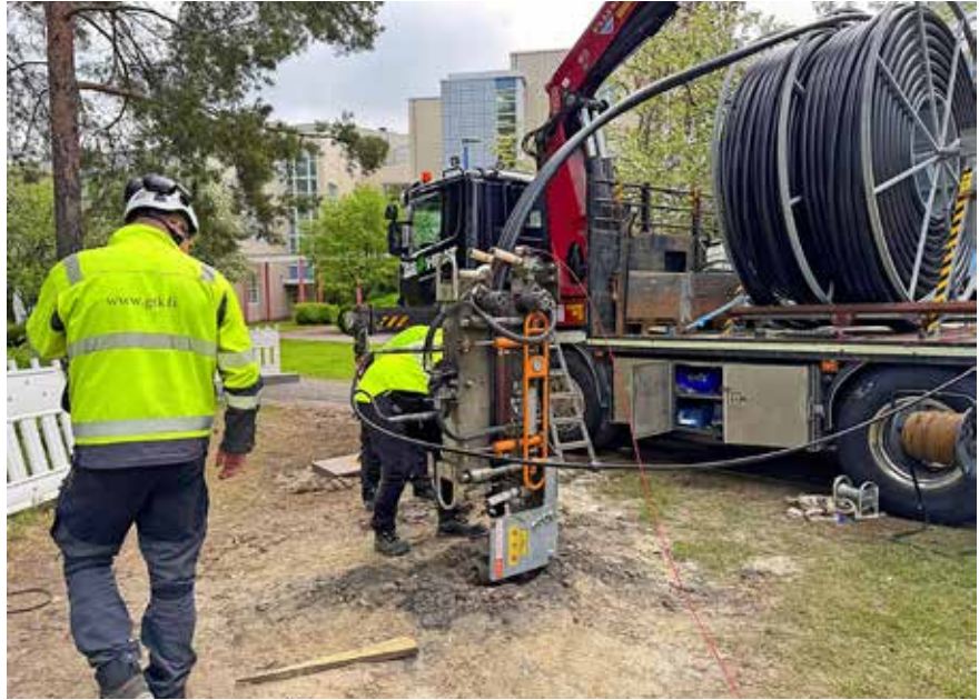
Oulun Linnanmaan kampuksen energiakaivon kollektoriasennus tehtiin kesällä 2025. Kuva: GTK.
