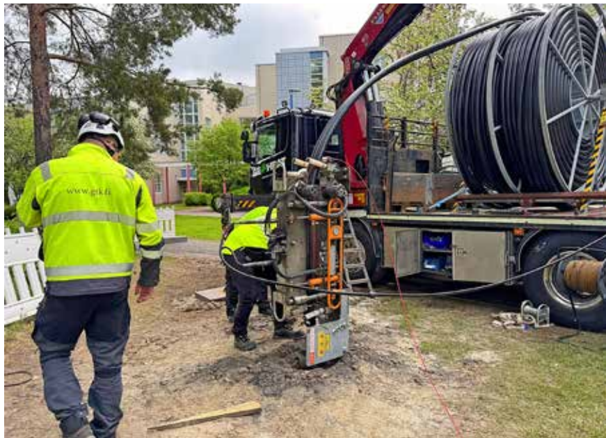
Oulun Linnanmaan kampuksen energiakaivon kollektoriasennus tehtiin kesällä 2025. Kuva: GTK.
